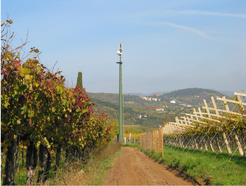
Zone Neutre Installazione di antenne su palo mimetizzato
